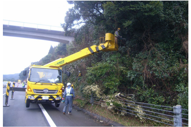
<樹木伐採作業>
