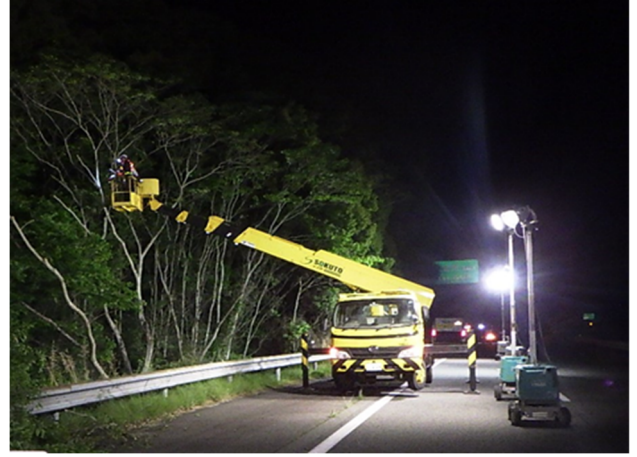
<樹木伐採作業>
