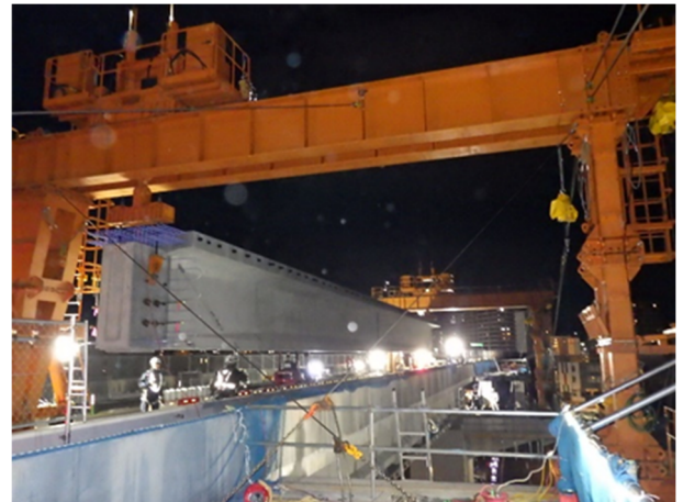
<橋梁桁架設>
