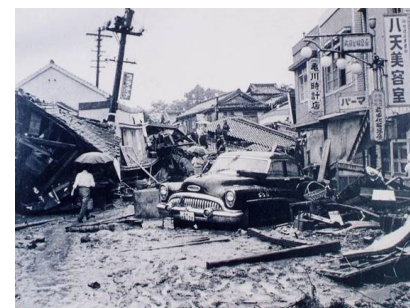
昭和32年7月洪水(八天町付近)
