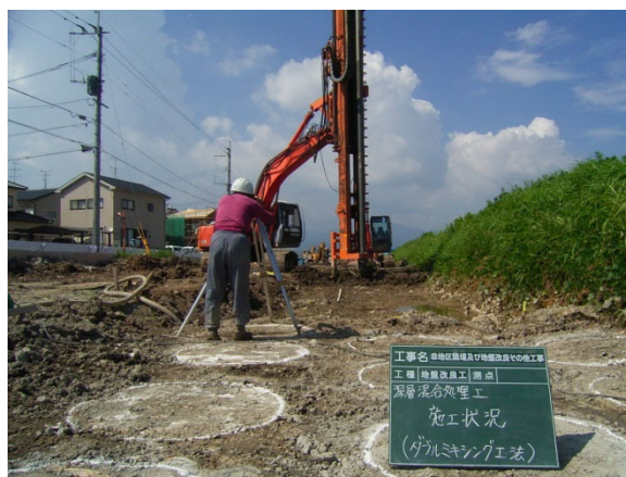
新技術による施工（地盤改良工）
