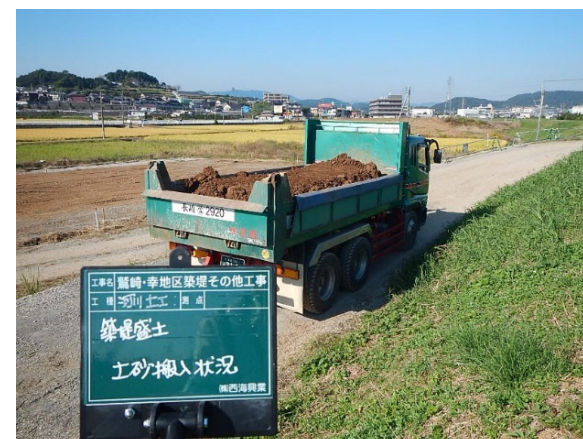
現地発生材の再利用（土砂搬入状況）
