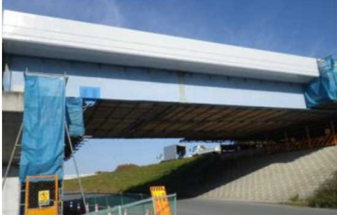
橋梁点検と補修工事で足場を共有
