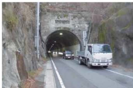
＜仁方隧道の状況＞
