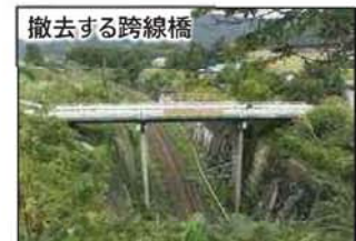
老朽化が進展した跨線橋を撤去し隣接橋へ機能を集約
