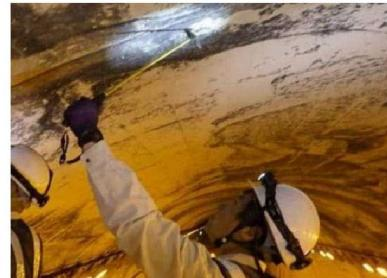
打音検査による覆工表面のうき・はく離等のたたき落とし
