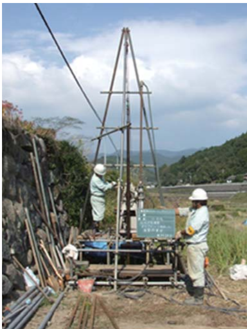
ボーリング調査により地中の地質状況を確認
