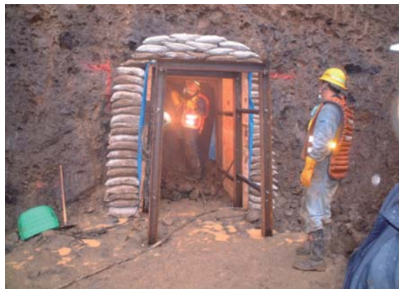
横坑（調査用トンネル）による地質状況の確認
