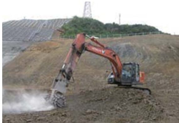
ダムの基礎として期待できない部分を取り除いた後にダムを造っていきます
