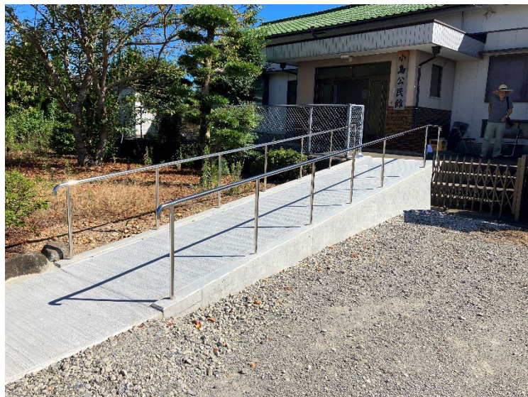
スロープ設置
