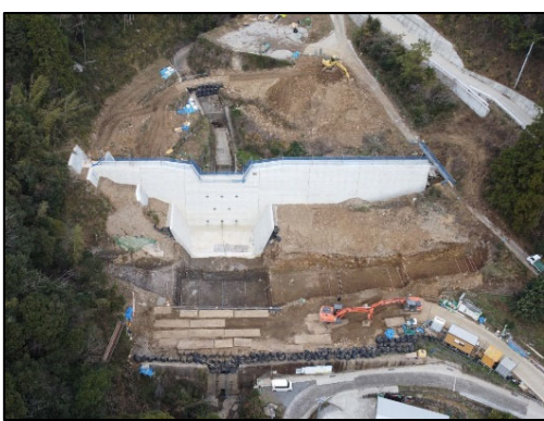
砂防施設の整備による土砂流出抑制(県)
