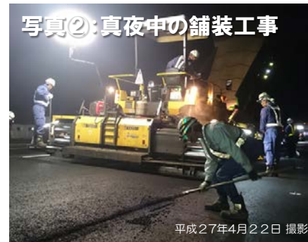
写真②：真夜中の舗装工事 花高入口交差点付近から本野入口交差点を望む 平成27年4月22日 撮影
