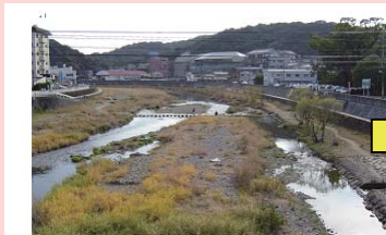
堆積土砂撤去前
