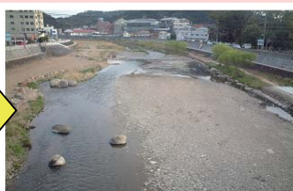
堆積土砂撤去後
