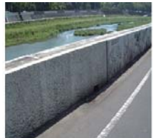
ひび割れ補強後の状況
