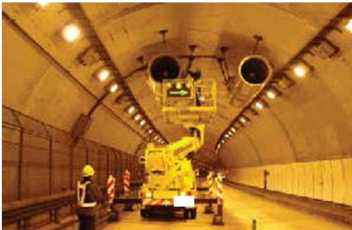
設備の近接目視点検
