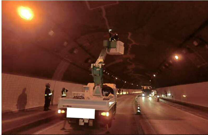
近接目視点検
