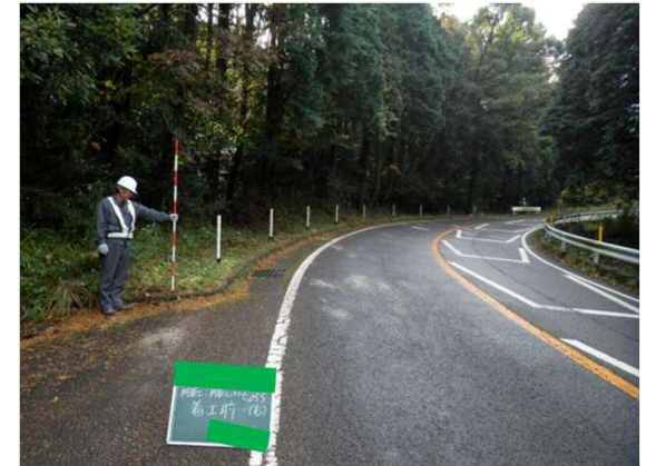
道路法面・路肩の防草対策
