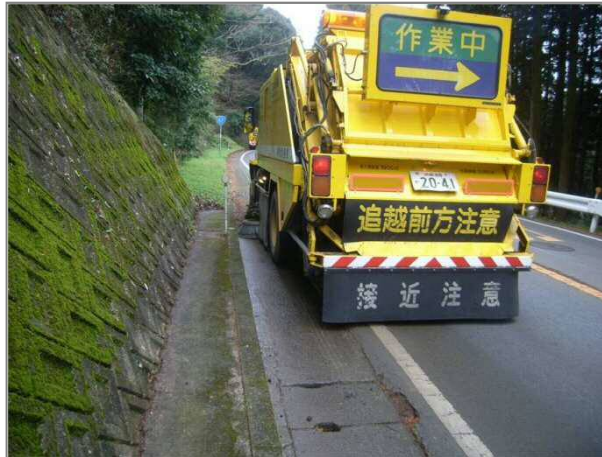
車道や歩道上の土や 枯葉等を取り除く
