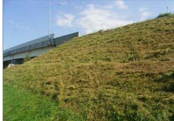
法面の雑草を除草
