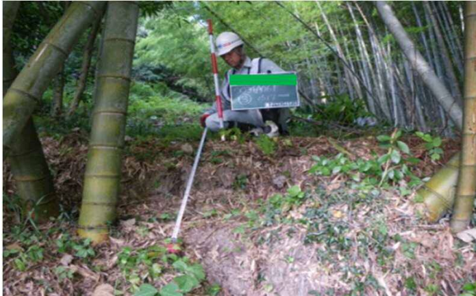
道路法面の点検
