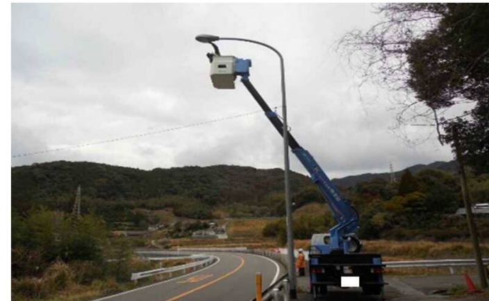
道路付属施設の点検
