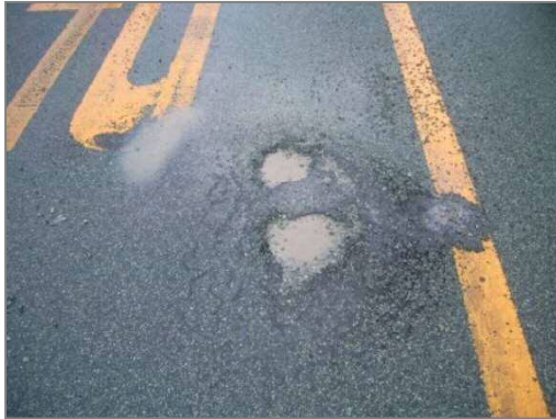
ポットホール（穴ぼこ）の補修
