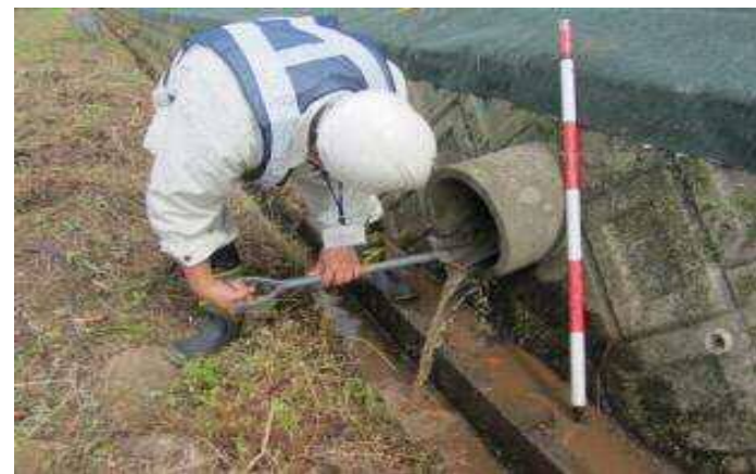
土構造物の点検
