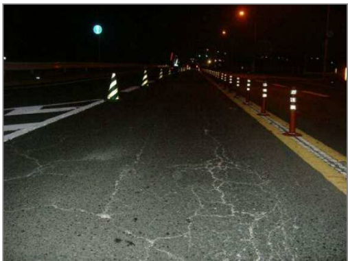
ひびわれの補修
