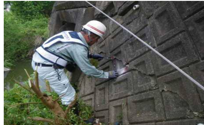
構造物の点検
