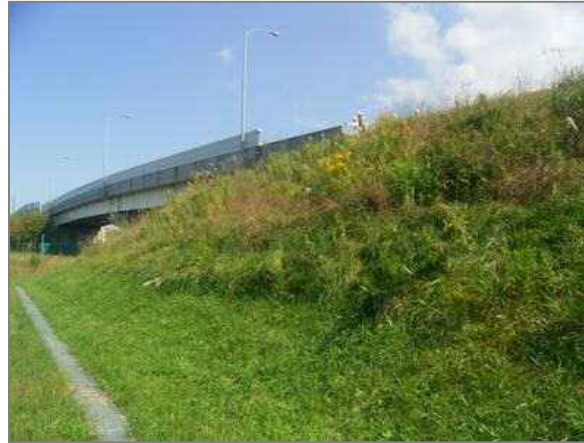
道路法面の除草
