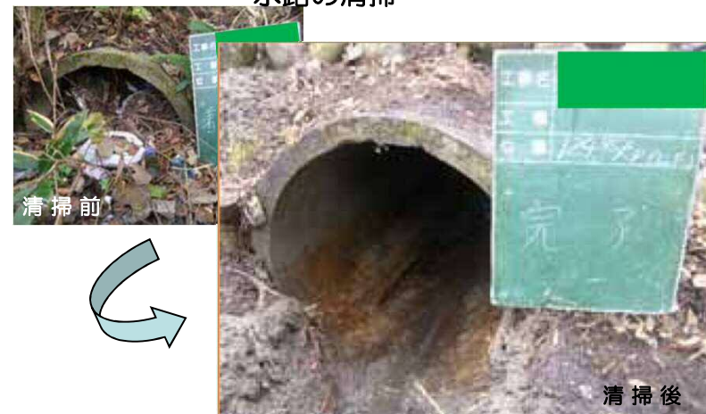
枯葉や泥の詰まった水路を清掃
