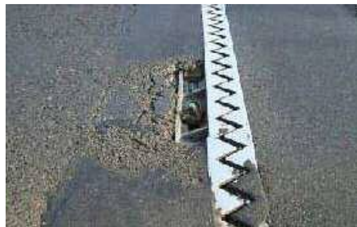
伸縮装置の点検
