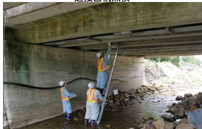
近接目視点検
