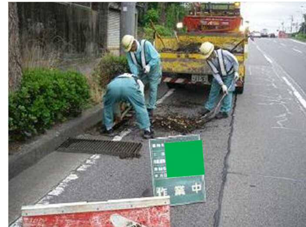
泥がたまった集水桝の清掃
