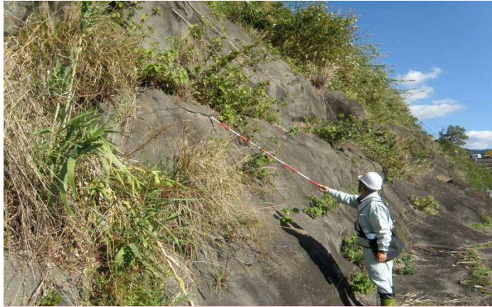
道路法面の点検
