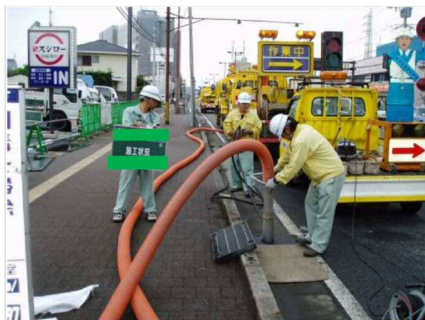
側溝清掃車を使用した土砂の撤去
