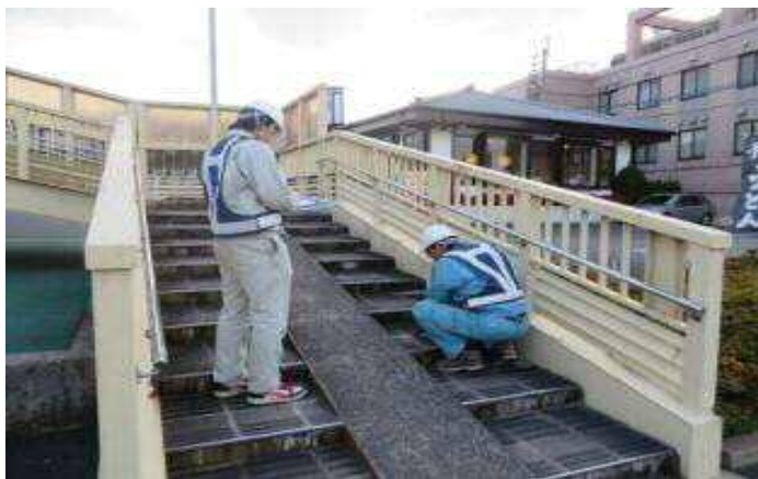
横断歩道橋の点検
