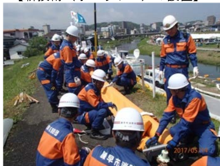
【新技術（水マット工）の設置】
