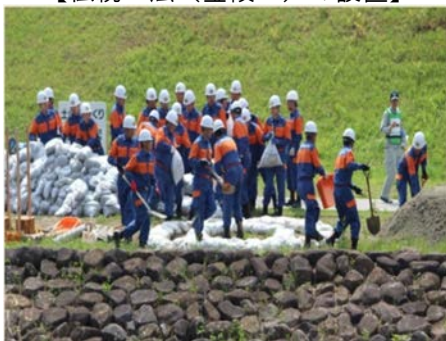
【伝統工法（釜段工）の設置】
