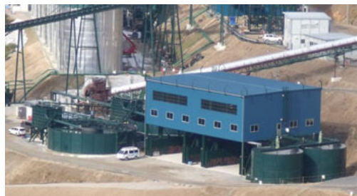
▲濁水処理設備(他ダム事例)
