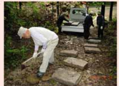
【石畳の設置作業】
