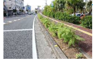
きれいになった国道57号
