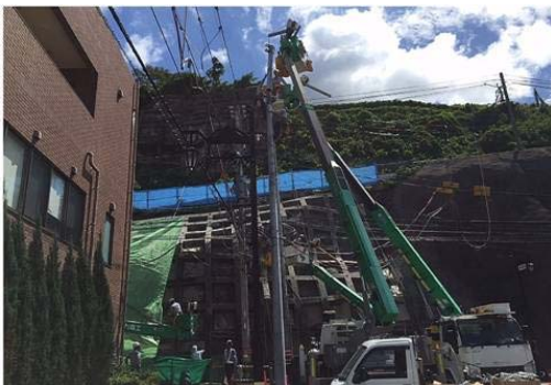
法面工事と電線張り替え工事施工中
