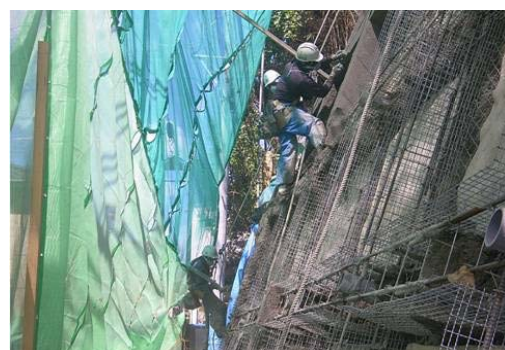
法面を補強する工事を実施中 施工: 榎田浦組
