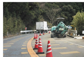
大浜上の国道57号災害復旧工事
