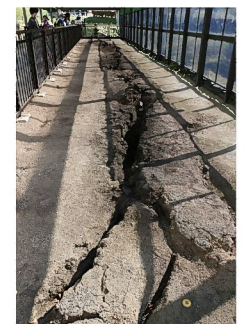
地表地震断層 震災遺構
