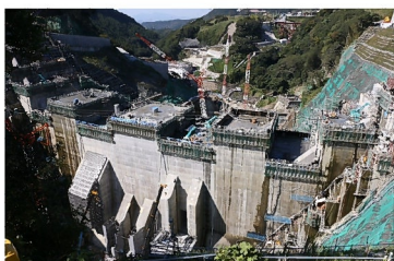
建設中の「立野ダム」 流水型(普段は水を貯めない)
