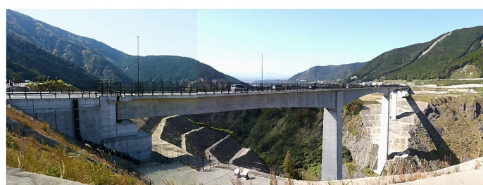
5年の短期間で開通した「新阿蘇大橋」長さ525m 橋脚高さ97m
