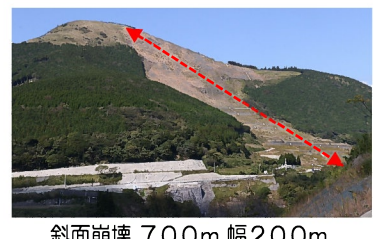
斜面崩壊 700m 幅200m JR豊肥線・国道57号・阿蘇大橋が崩壊 4年の短期間で復旧
