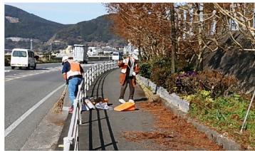
2月15日（水曜日） 国道57号赤崎歩道
