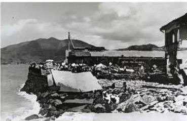
台風14号 道路崩壊 現 バスターミナル付近
