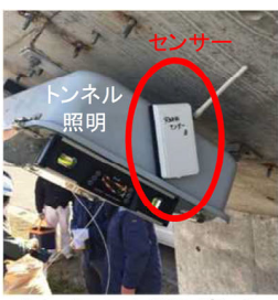
トンネル内附属物の 異常監視センサー
