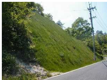
切土(法面保護)
