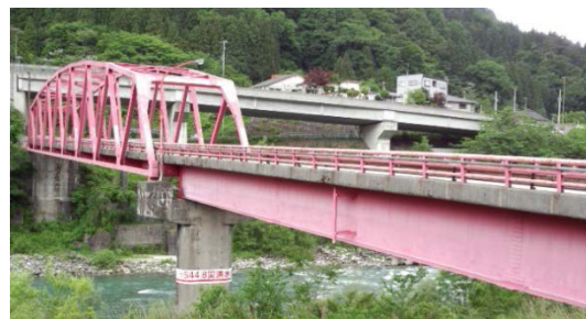
<音沢橋の状況>
