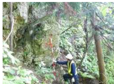
(危険度調査状況)
