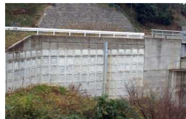
盛土(補強土壁)
