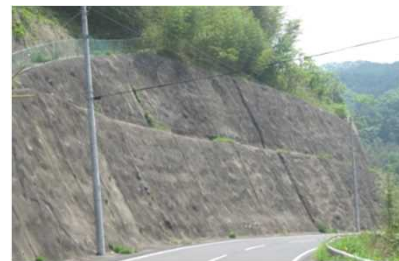
モルタル吹付
