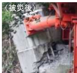
制震ダンパー取付部の損傷
