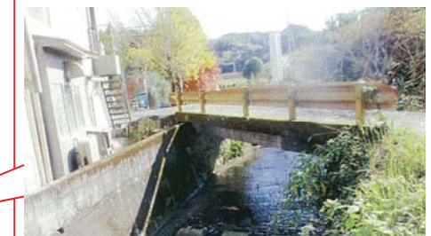
老朽橋の撤去
