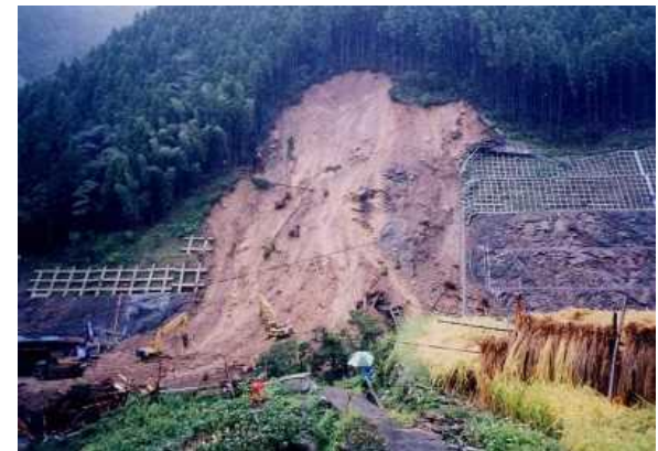
強風化・土砂化斜面での崩壊例
