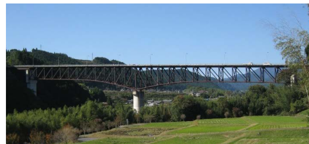
<乙姫大橋の状況>
