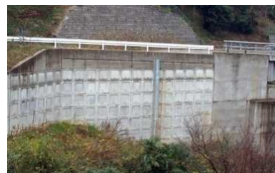
盛土（補強土壁）
