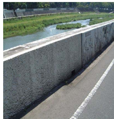
ひび割れ補強後の状況
