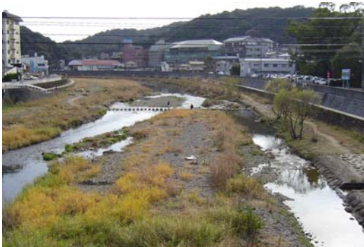
堆積土砂撤去前
