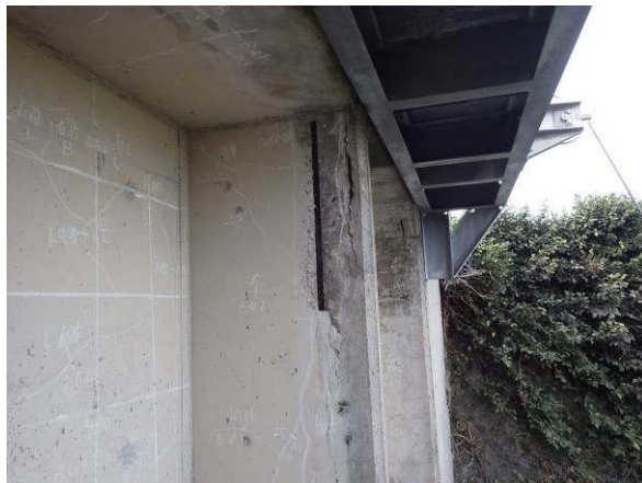
写真2-1-4 長田第5樋門の鉄筋
