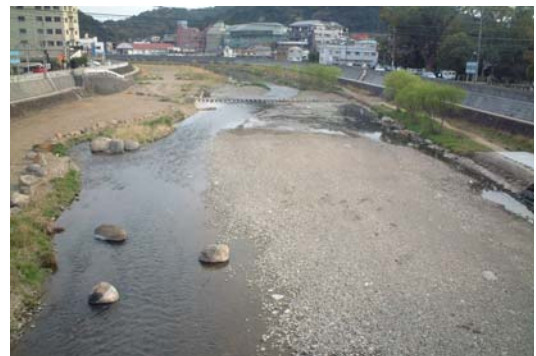
堆積土砂撤去後
