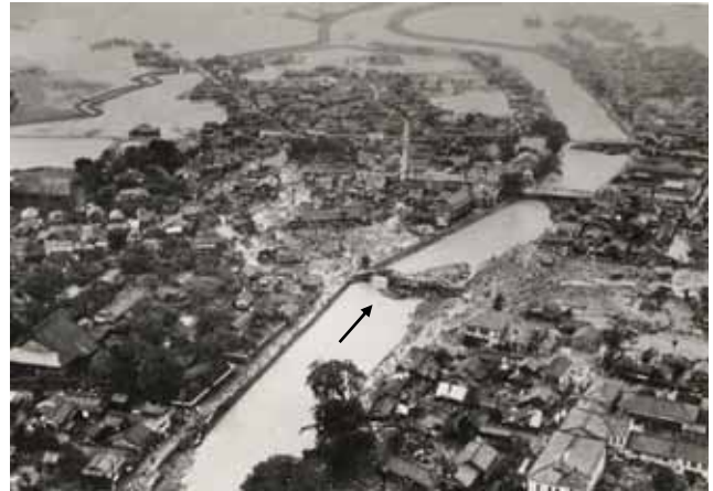
被災した諫早市街地の状況
