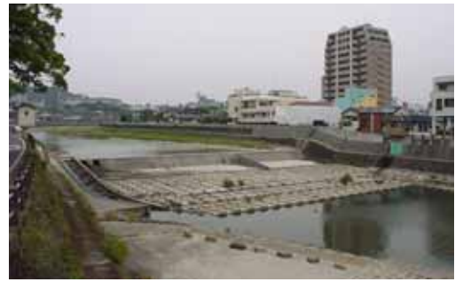
写真1-3-1 公園堰(本明川 5k000 付近)
