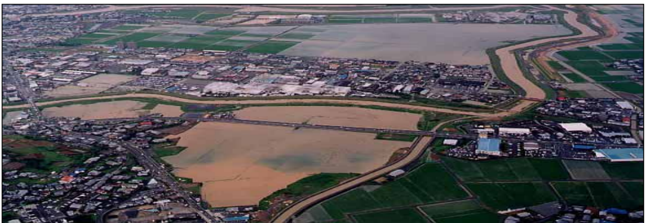
半造川周辺の浸水状況
