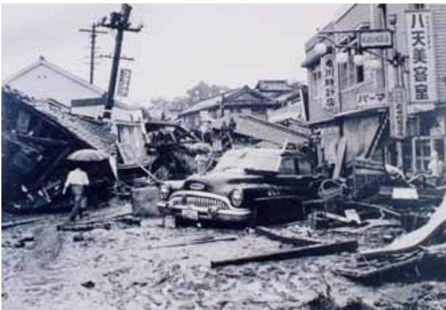
八天町の家屋倒壊の状況
