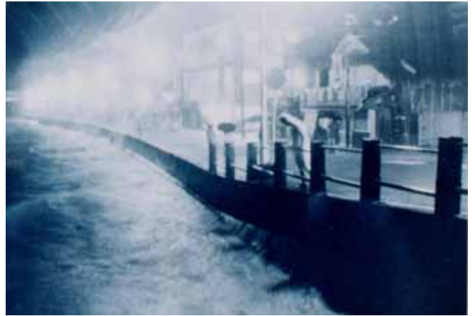
高城橋付近の洪水の状況
