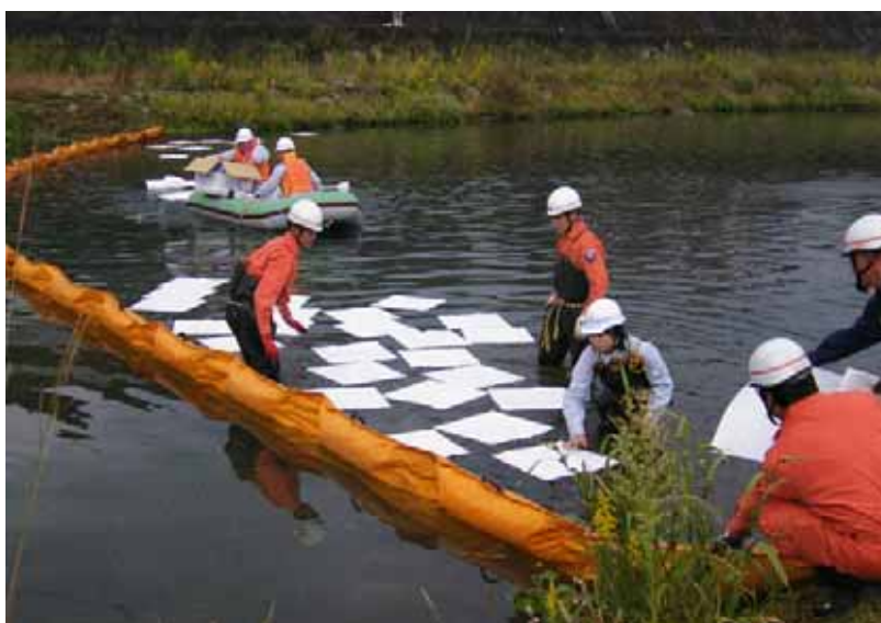
写真4 - 3 - 11 オイルフェンス、吸着マットの設置状況 (水質事故訓練にて)
