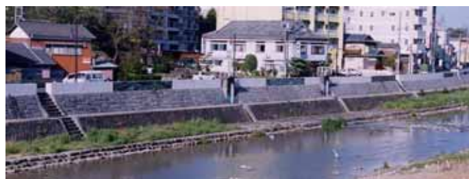
写真2-1-1 中流部の河川管理施設(特殊堤・樋門・陸閘)
