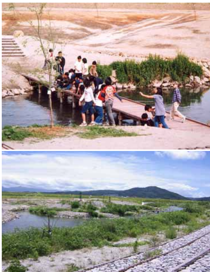
写真4 - 2 - 1 環境に配慮した水辺の整備
