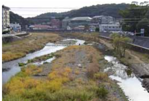
堆積土砂撤去前
