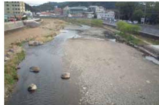
堆積土砂撤去後
