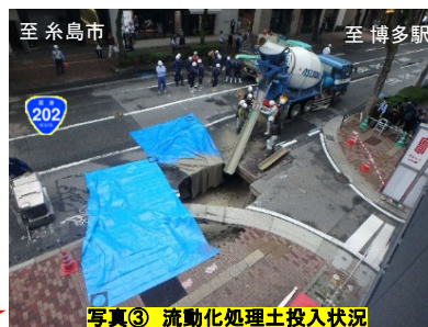
写真③ 流動化処理土投入状況
