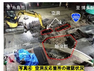
写真④ 空洞反応箇所の確認状況
