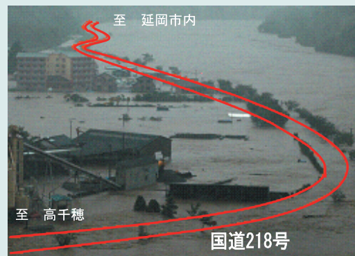
国道218号 北方町総合支所付近の冠水状況(H17.9)
