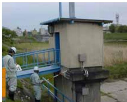
写真 4-3-1 樋門の補修点検
