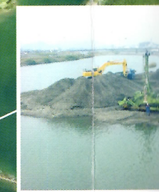
河道掘削(大瀬川下流)
