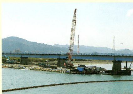
河道掘削（鷺島橋付近）
