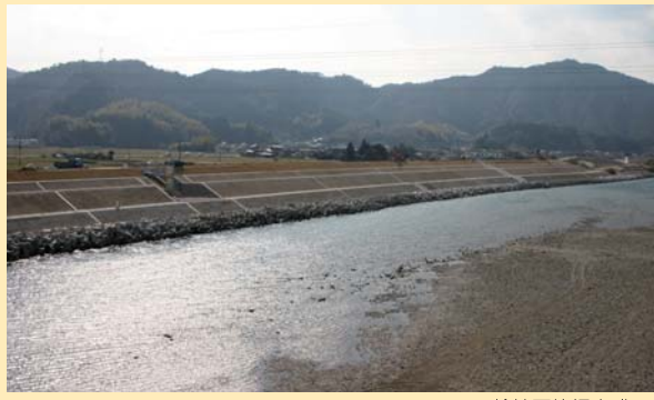
三輪地区築堤完成
