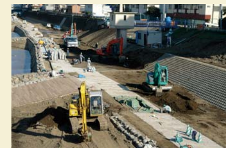
五ヶ瀬川の亀井橋下流
