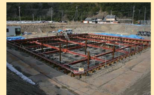
道内川排水ポンプ場の状況
