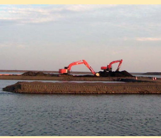
河口での河道掘削状況
