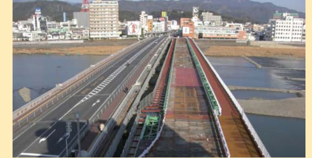
安賀多橋架替の状況
