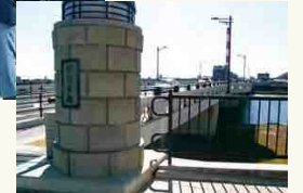
▲完成した安賀多橋
