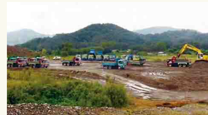
▲延岡市クリアパーク造成事業への掘削土砂の提供状況
