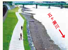
▲工事完成後の状況
