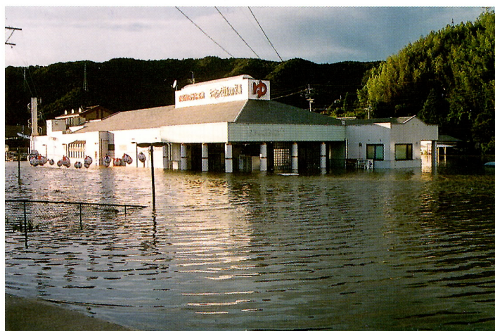
五ヶ瀬川左岸古川町 浸水状況
