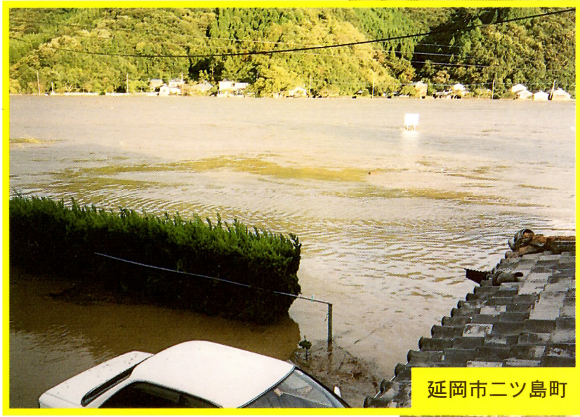
北川右岸二ツ島町 越水状況
