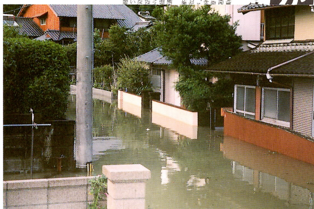
北川左岸東海町 浸水状況
