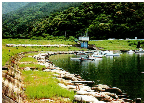
土の間詰め直後の状態
