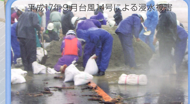
越水防止の為、土嚢を積み上げる人々
