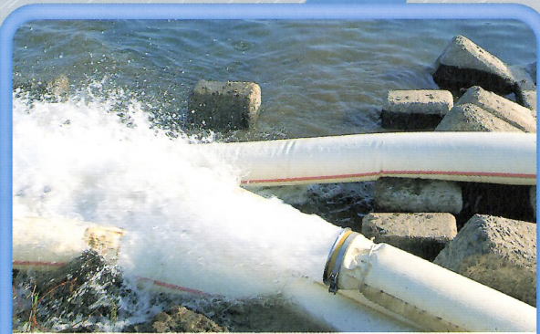
ポンプより汲み上げられた河川水を排水
