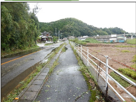
行藤川堤内痕跡状況(9月19日09:40頃)
