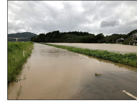
五ヶ瀬川左岸8k600付近堤内(9月19日07:00頃)
