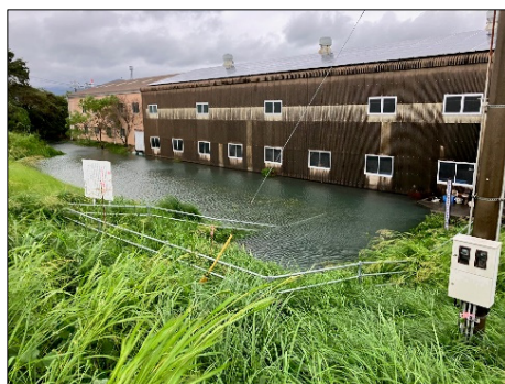
祝子川右岸1k200付近堤内(9月19日08:00頃)
