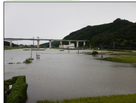
五ヶ瀬川右岸9k600付近堤内(9月19日09:00頃)
