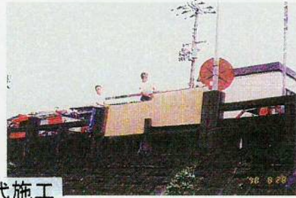
昭和30年代施工
