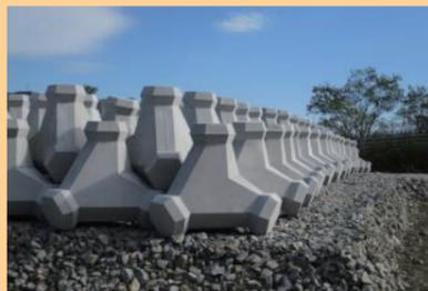
根固めブロックは、川底や河岸などが削られないように設置するコンクリートブロックです。あらかじめ緊急復旧に必要な資材として備蓄(約2300個)しています。
