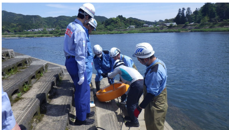
ポンプ設置状況
