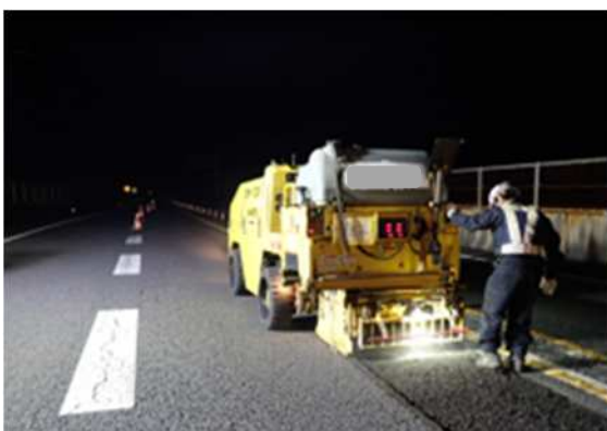
＜舗装補修工事＞
