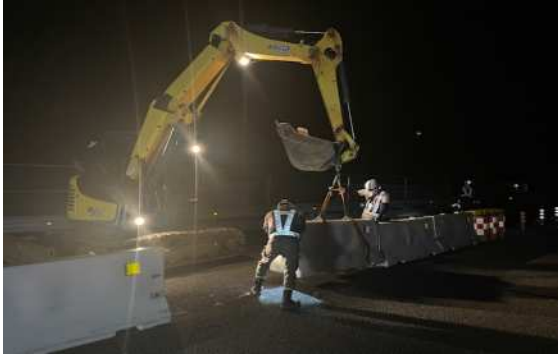
＜仮設防護柵設置工事＞
