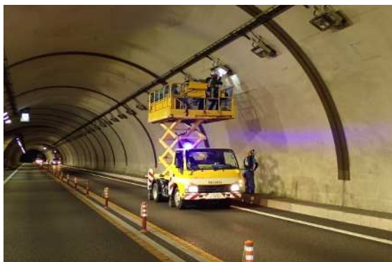
＜トンネル照明点検作業＞
