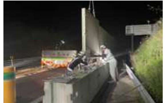
＜バリアウォール移設作業＞
