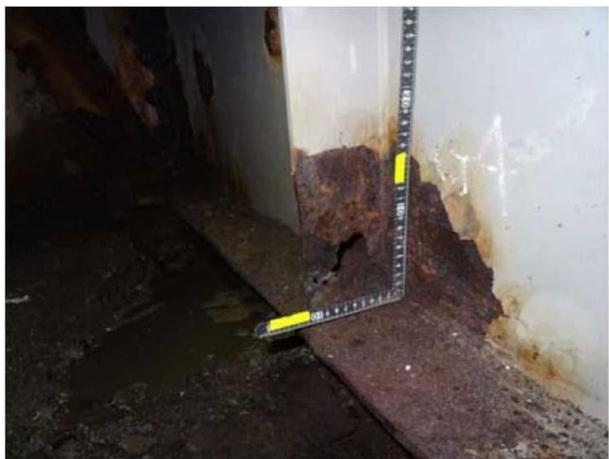
国管理 主桁腐食・欠損
