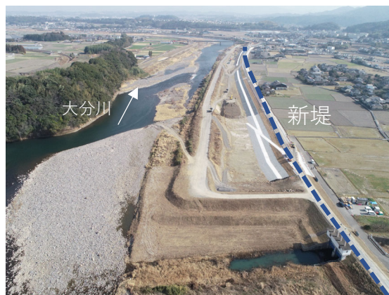
【施工前】 令和3年1月撮影
