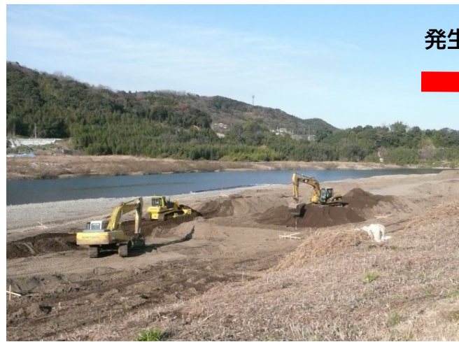
河道掘削状況
