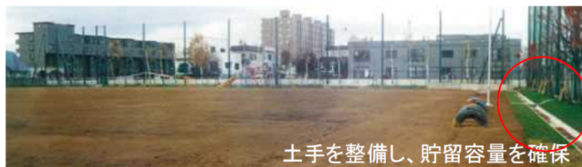
(事例)校庭を活用した流域貯留施設
