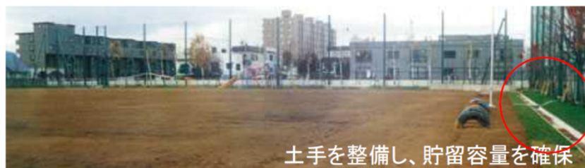
(事例)校庭を活用した流域貯留施設
