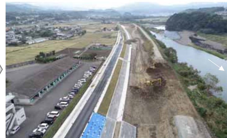
【現況】 国分橋より上流
