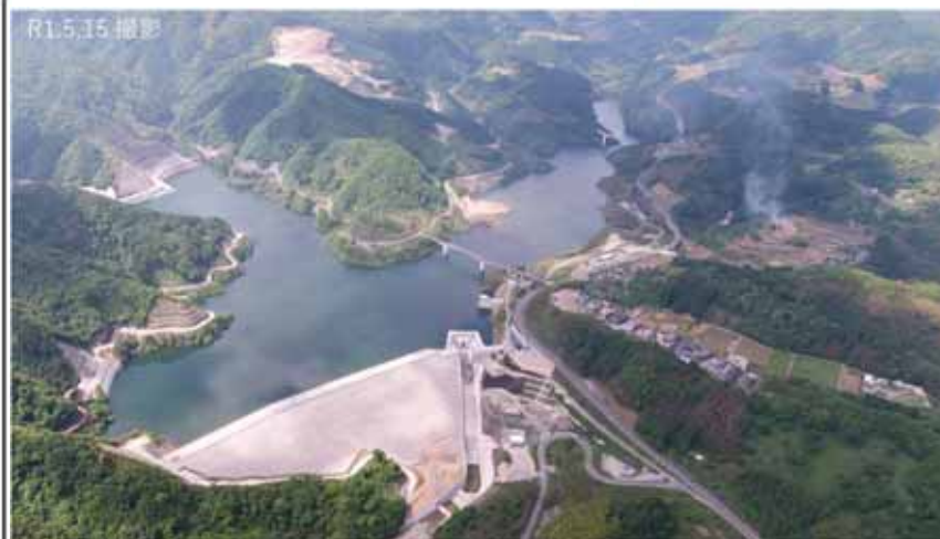
大分川ダムの状況写真（R1.5.15撮影）
