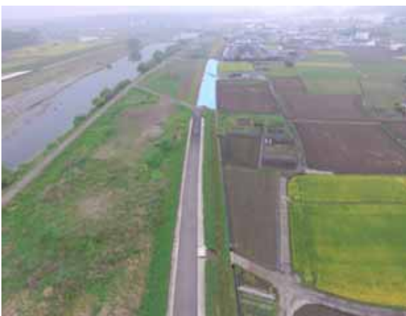
【施工前】 国分橋より上流
