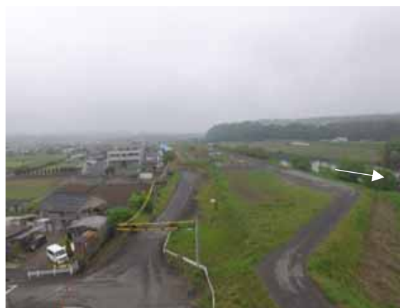
【施工前】 国分橋より上流
