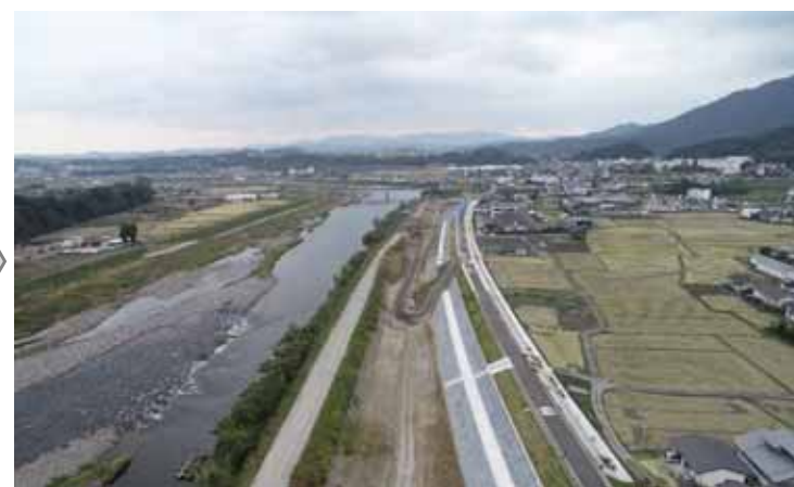
【現況】 国分橋より上流
