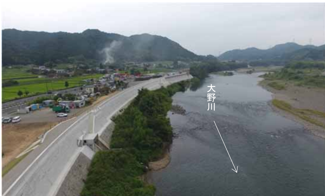
利光地区築堤（完了）
