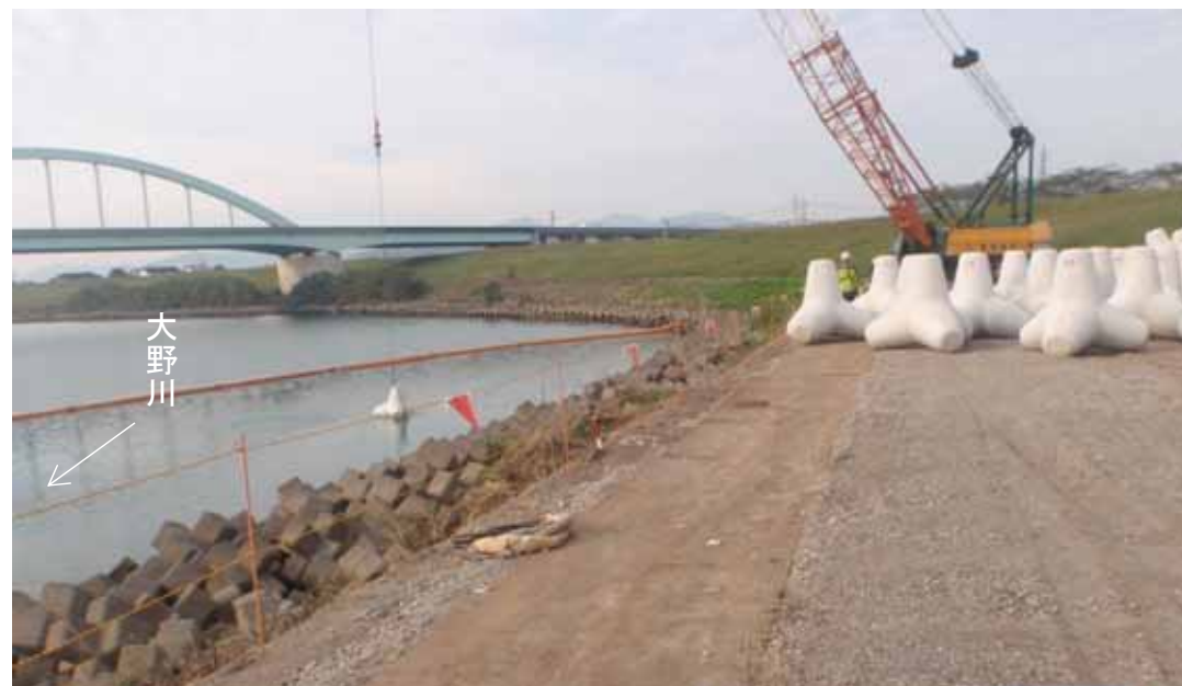
大津留地区河床低下対策（左岸8/400～8/600）
