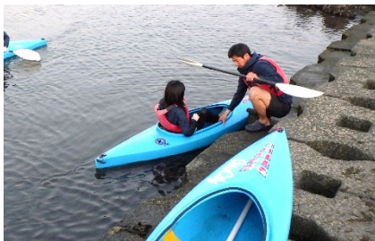
低水護岸のステップが干潮時に干出しカヌーの安全な乗降ができない
