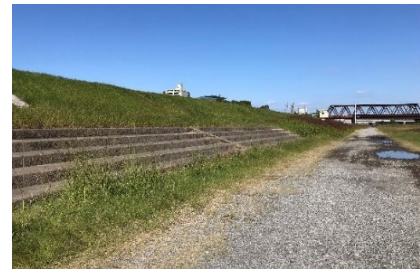
既存の観覧用階段は段差が大きく通行が困難管理用通路は未舗装で不陸が生じている
