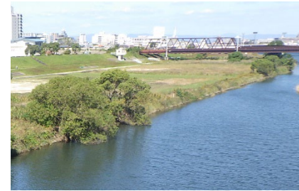
親水施設が整備されておらず草木の繁茂で水際を通行できない
