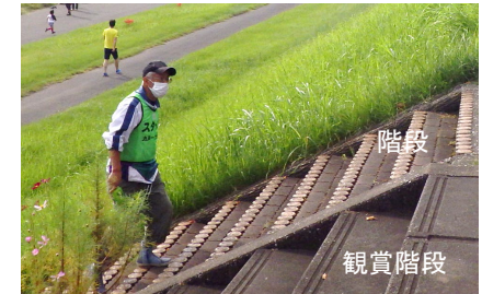
階段幅が狭く、カヌーを2人で並んで安全に運ぶことができない
