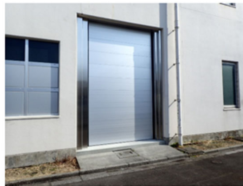
防水シャッターの設置
