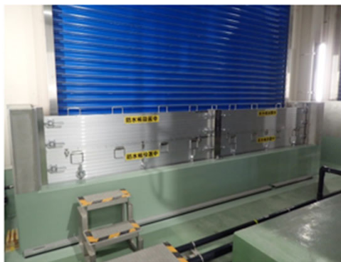
止水板の設置
