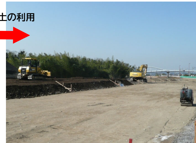
堤防整備状況
