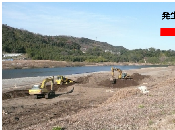
河道掘削状況
