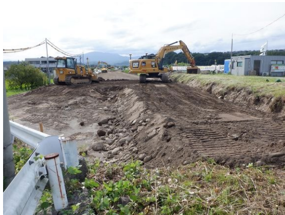
ICT建設機械による河道掘削事例 (国分地区)
