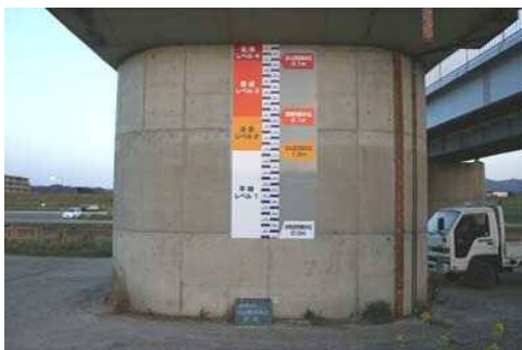
乙津川高田橋の橋脚
